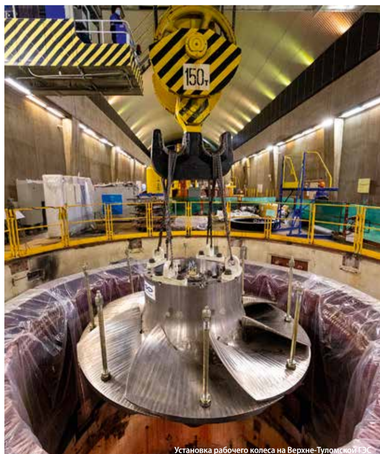
Установка рабочего колеса на Верхне-Тулумской ГЭС
