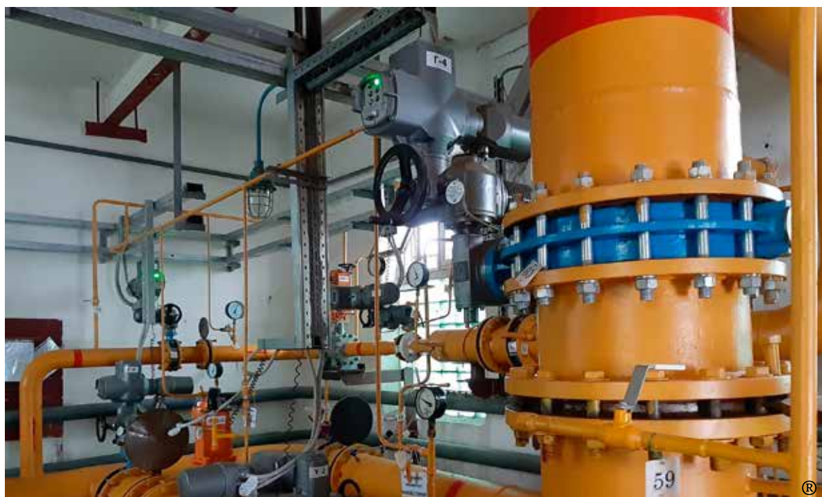
Основная нитка № 2 и растопочная нитка № 3 с новым установленным оборудованием (затворы, ПЗК, регуляторы давления)
