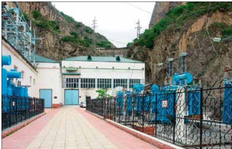
Фото 4 (вверху слева). Трансформаторы Гергебильской ГЭС
